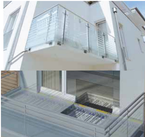
Schöck Rutherma assure la continuité de l'isolation du bâtiment.
